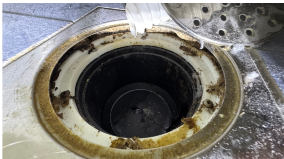
Kontroll av sluk.
