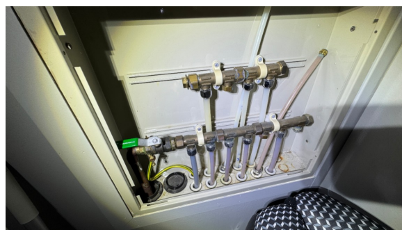
Kontroll av rørfordelerskap.
