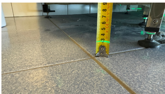
Kontroll av fallforhold.
