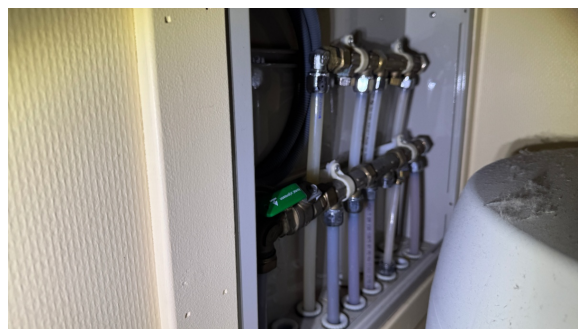
Kontroll av rørfordelerskap.
