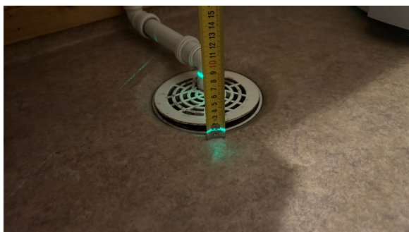
Kontroll av fallforhold.
