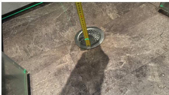
Kontroll av fallforhold.
