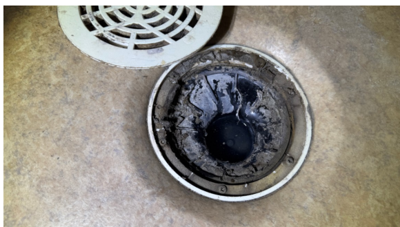
Kontroll av sluk.
