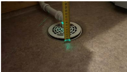
Kontroll av fallforhold.
