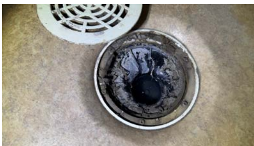
Kontroll av sluk.
