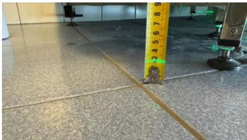
Kontroll av fallforhold.
