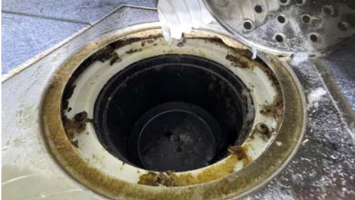
Kontroll av sluk.
