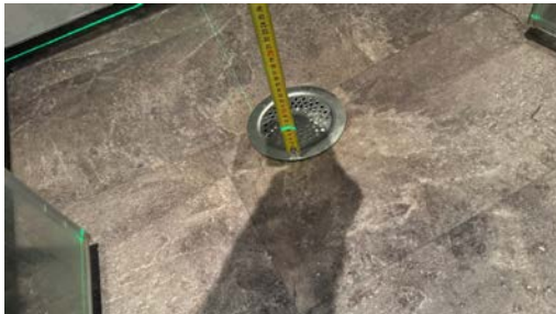
Kontroll av fallforhold.
