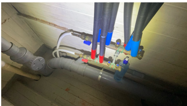
Rørfordeling kott til bad (ikke sluk)
