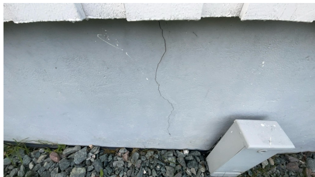
Gavl mot vei utv.
