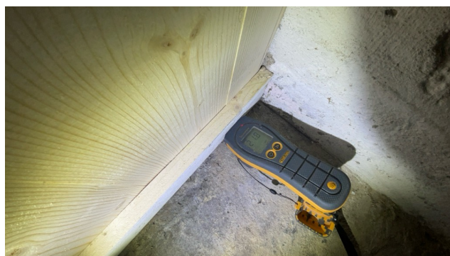
22vekt% ved måling av treskillevegg mot betonggulv/mur-yttervegg
