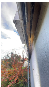
Utlektet med liggende lekt hvor panelende kan synes
