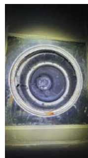
Ikke synlig tettelsesringer (da det er avdekninger på rør)
