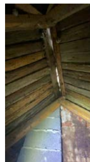
Ikke spesiell ventilering ved raft/skråhimling eller gavler opprinnelig del
