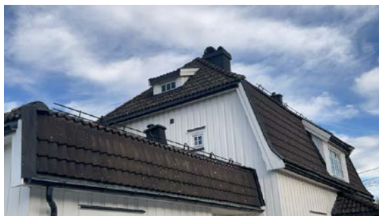
Oversiktsbilde ulike takbeslag
