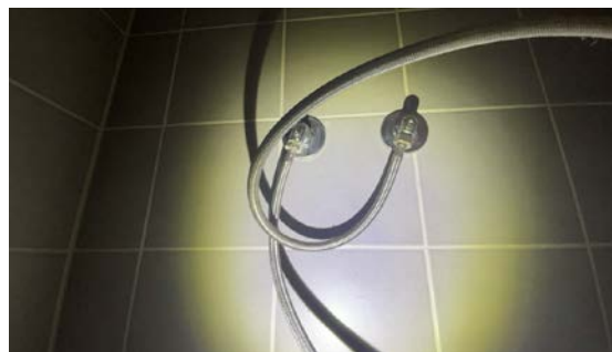
Ikke synlig tettelsesringer (da det er avdekninger på rør)
