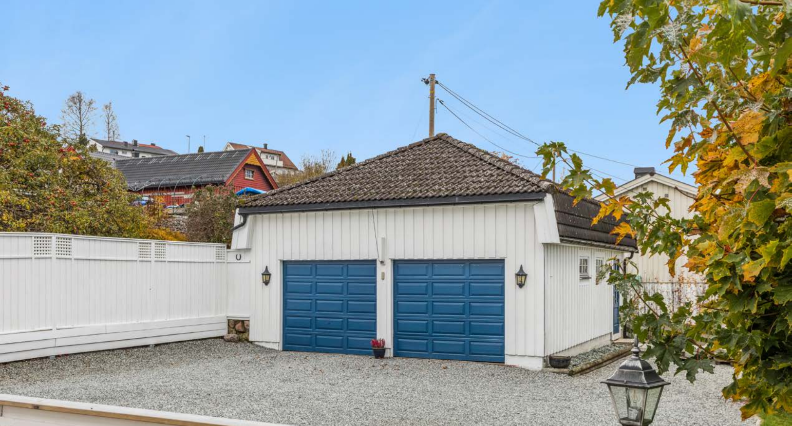
Dobbel garasje med lagringsloft.
