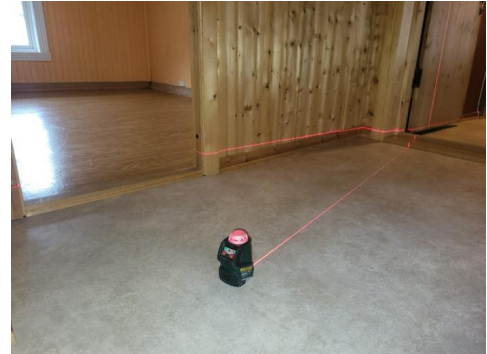
Måling av planavvik i loftetasjen.
