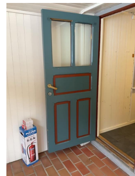
Malt inngangsdør fra vindfang.
