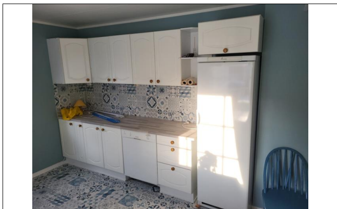
Fjøs, kjøkkeninnredning i 2. etasje.
