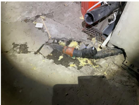
Avløpsrør i kjeller.
