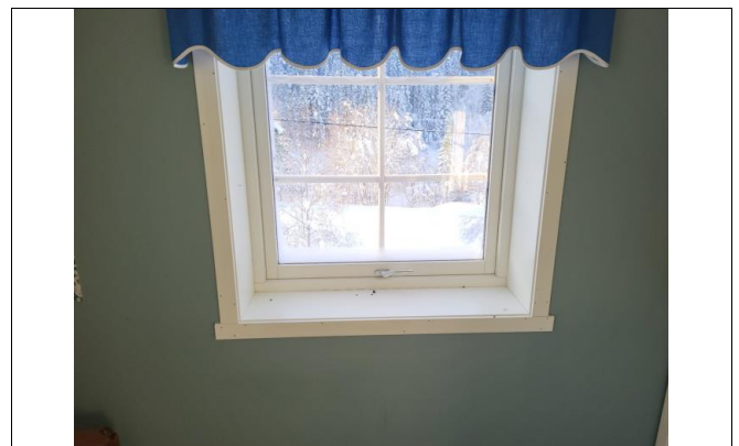
Fjøs, innsatt nye vinduer i 2. etasje på kjøkken.
