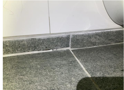
Utett silikonerings ved gulv.
