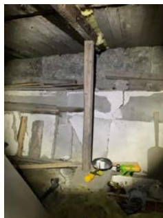
Midlertidig understøttelse av bjelkelag.
