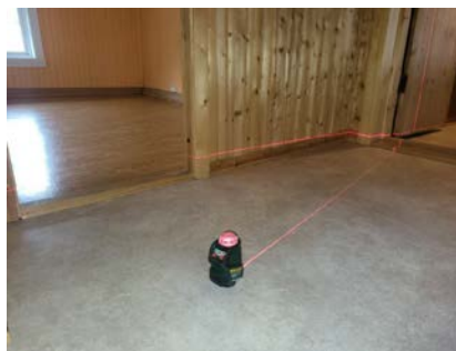
Måling av planavvik i loftetasjen.
