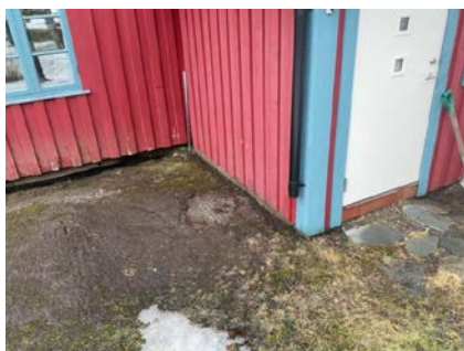
Manglende takrenner på hovedtak.
