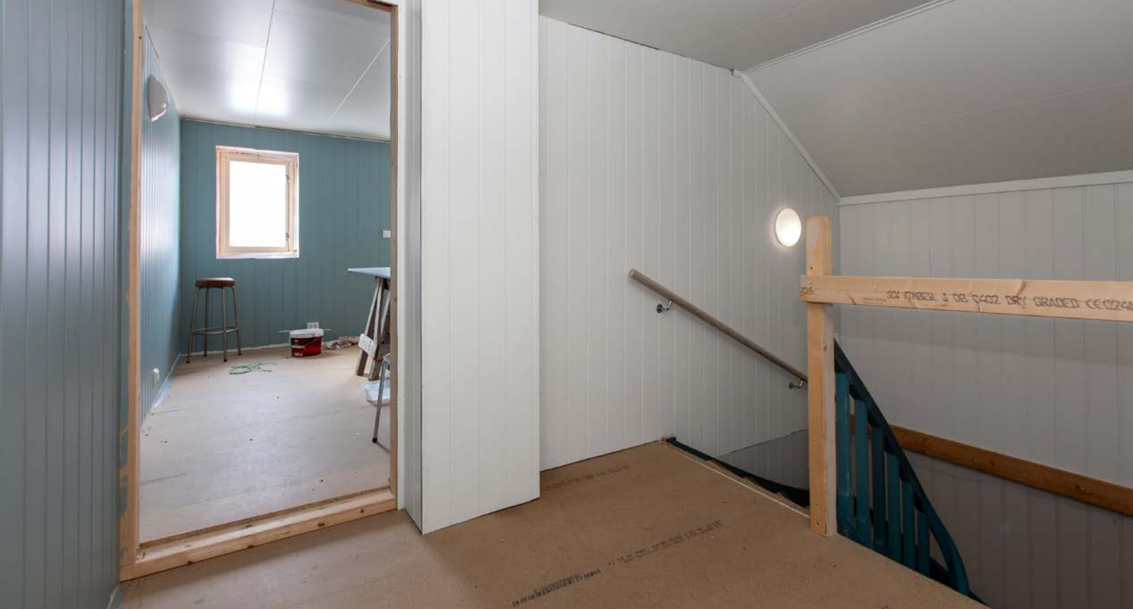
Trappegang og rom i 3.etg.
