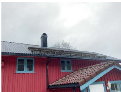
Manglende takrenner på hovedtak.
