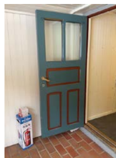
Malt inngangsdør fra vindfang.
