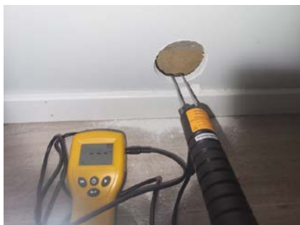
Fuktmåling innvendig i veggkonstruksjon mot bad.
