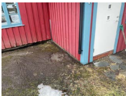
Manglende takrenner på hovedtak.
