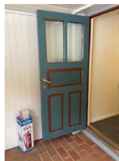
Malt inngangsdør fra vindfang.
