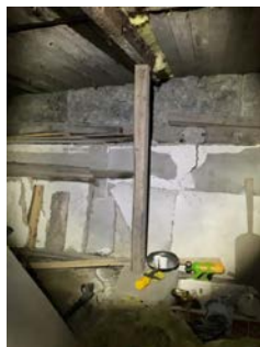
Midlertidig understøttelse av bjelkelag.
