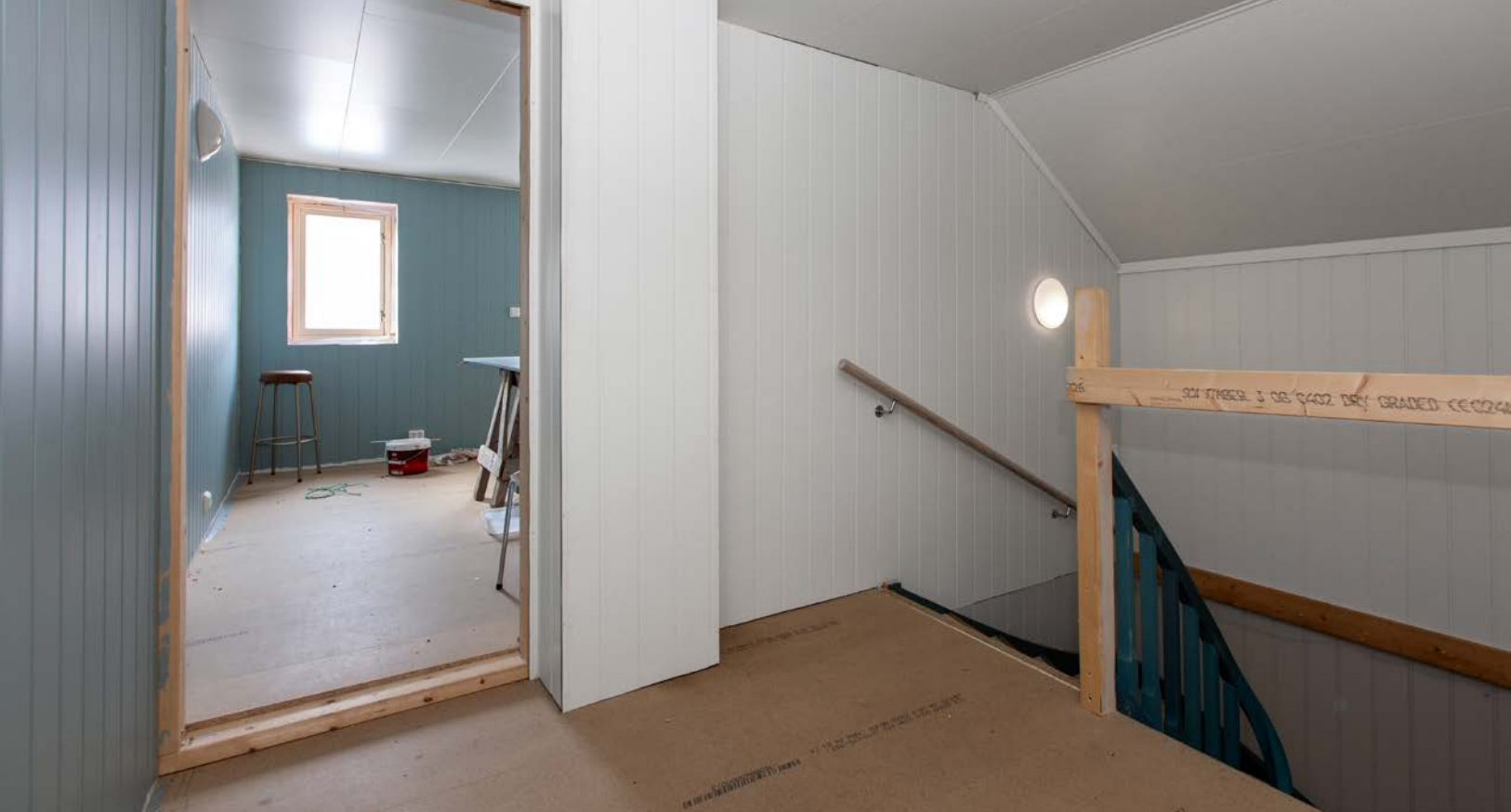
Trappegang og rom i 3.etg.
