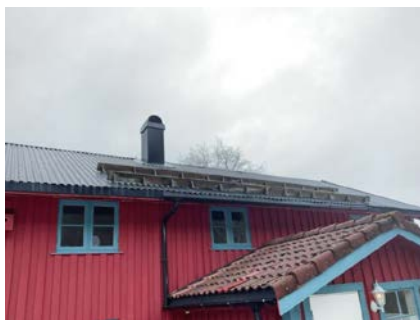
Manglende takrenner på hovedtak.
