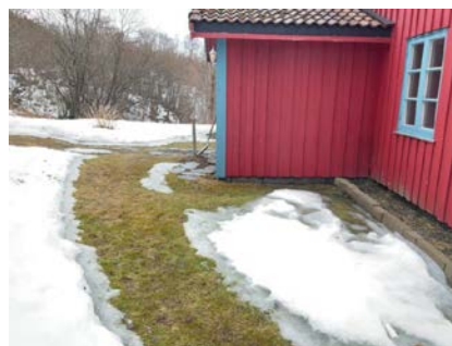
Inngangsparti med kryperom under bjelkelag.
