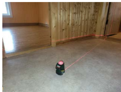
Måling av planavvik i loftetasjen.
