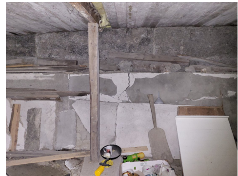
Grunnmur mot sør med trepillar som støtte under bjelkelag.
