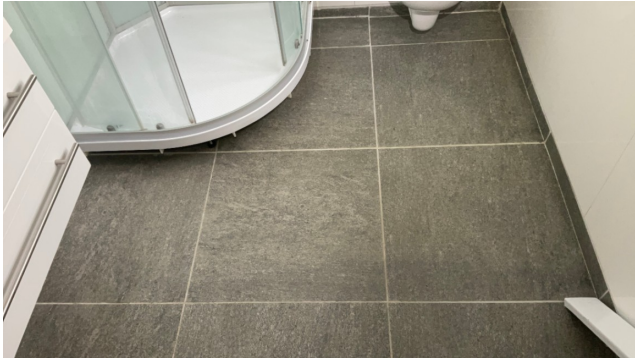
Fliser på gulv.
