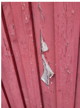
Malingsavflassing og sprekker i kledning.
