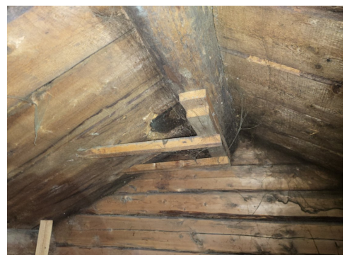
Takkonstruksjon mot sør.
