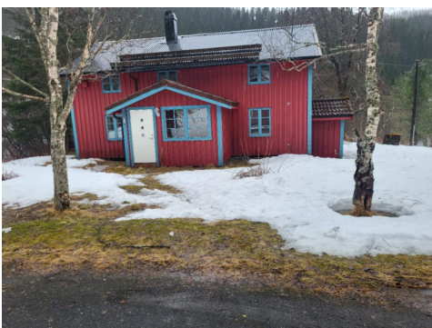
Vindfang er oppsatt med krypkjeller.
