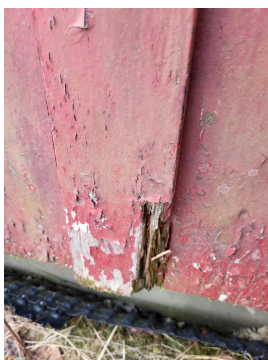
Malingsavflassing og sprekker i kledning.
