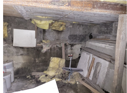
Grunnmur mot øst.
