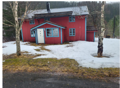
Plassbygde snøfingere på deler av taket.
