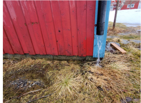
Krypkjeller fundamentert på lettklinker.
