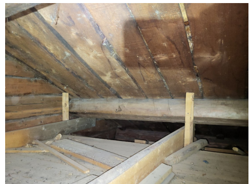
Takkonstruksjon mot sør.
