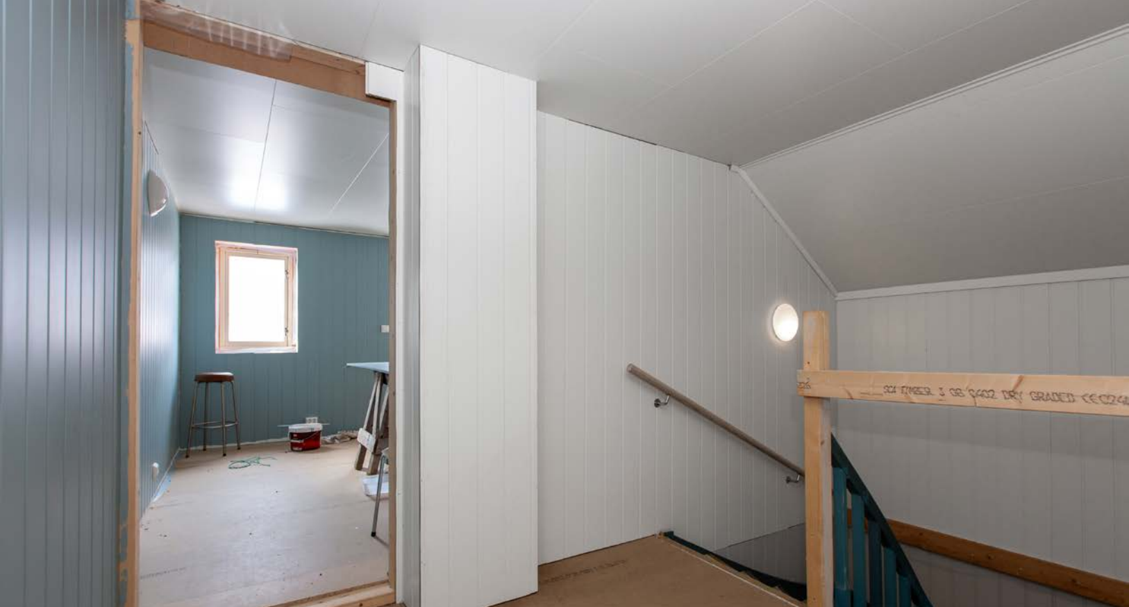
Fra fjøs som er omsøkt til annek: Trappegang og rom i 3.etg.
