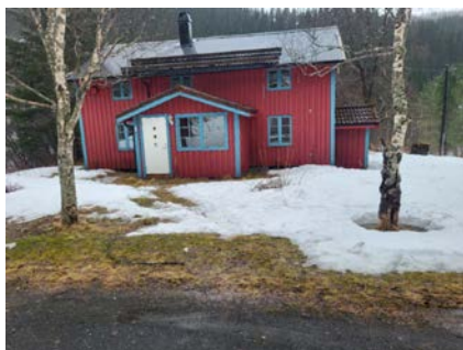
Vindfang er oppsatt med krypkjeller.
