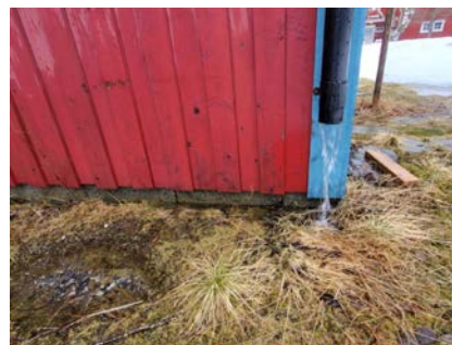
Krypkjeller fundamentert på lettklinker.
