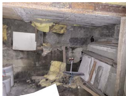
Grunnmur mot øst.
