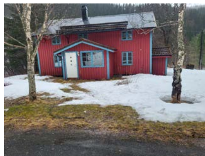
Plassbygde snøfangere på deler av taket.
