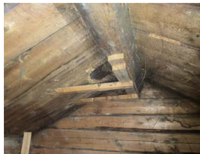
Takkonstruksjon mot sør.
