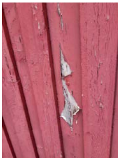
Malingsavflassing og sprekker i kledning.
