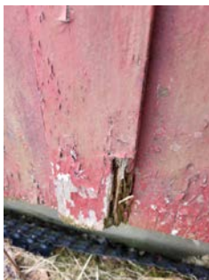
Malingsavflassing og sprekker i kledning.
