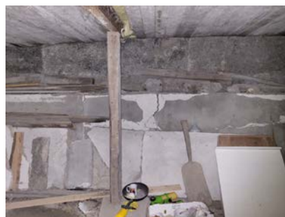
Grunnmur mot sør med tretpilar som støtte under bjelkelag.
