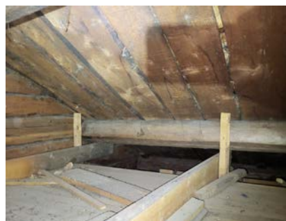
Takkonstruksjon mot sør.
