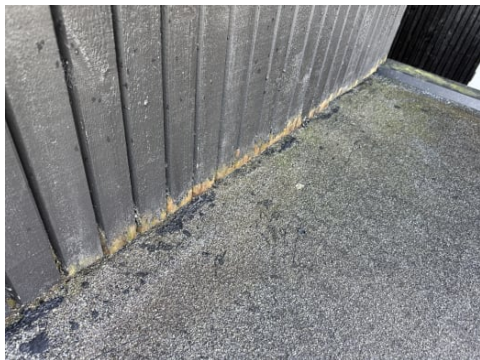
Tak over utv. bod, nedbrytning/råte i kledning yttervegg.
