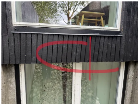
Tak over utv. bod, nedbrytning/råte i kledning yttervegg.
