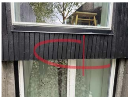
Tak over utv. bod, nedbrytning i kledning yttervegg.
