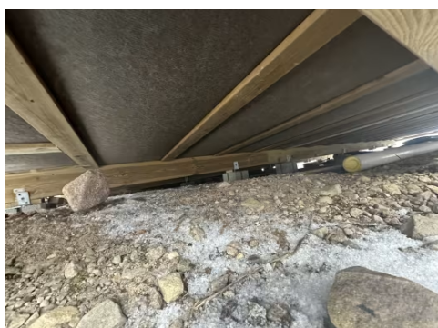
Stubbloftshimling med vindspærreplater ved tilbygg.
