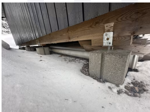
Viser fundamentering ved tilbygget del.
