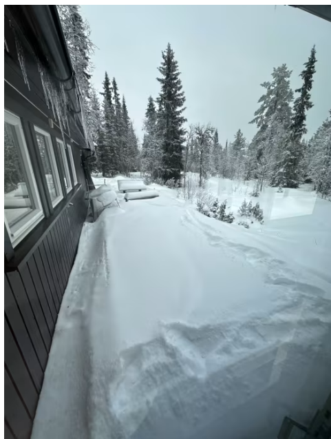
Viser terrasse med adkomst fra stue og terreng. Ikke etablert rekkverk.
