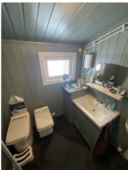
Viser forbrenningstoalett, urinal og innredning.
