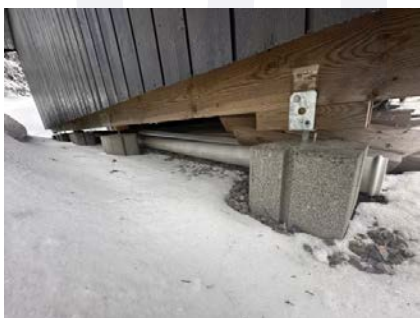
Viser fundamentering ved tilbygget del.
