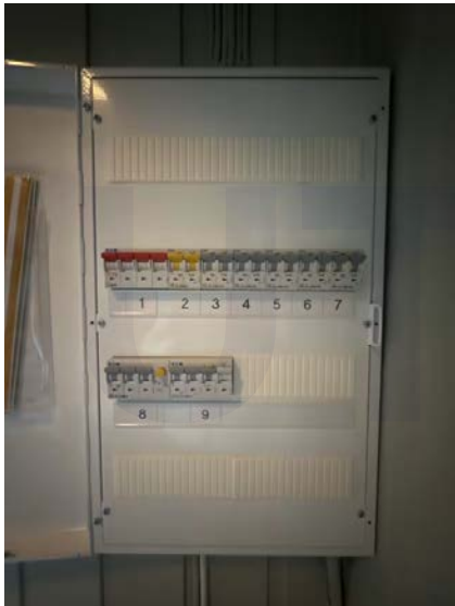
Viser sikringsskap på soverom.
