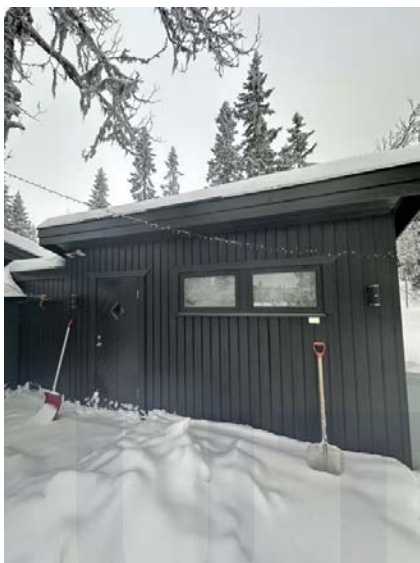
Viser boder med utvendig adkomst.
