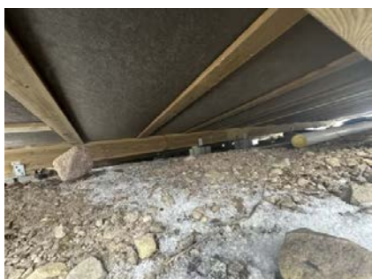
Stubbeloftshimling med vindspærreplater ved tilbygg.
