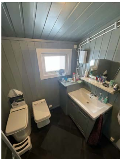
Viser forbrenningstoalett, urinal og innredning.
