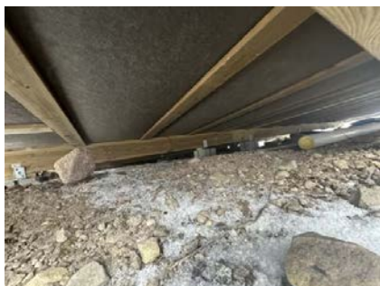
Stubbloftshimling med vindsperreplater ved tilbygg.
