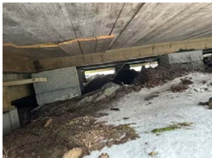
Stubbloftshimling med trebord ved opprinnelig del. Synlig sprekk/åpning i stubbloftshimling med trebord.
