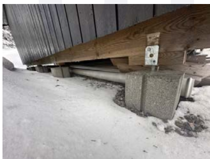
Viser fundamentering ved tilbygget del.
