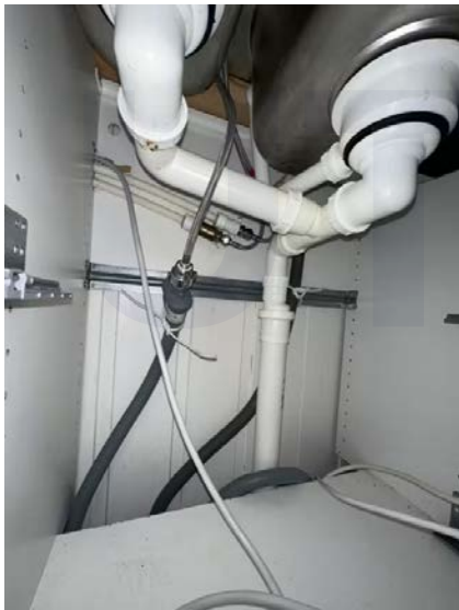
Viser vann og avløpsinnstallasjoner under kum. Røroppheng fremstår som en provisorisk løsning.
