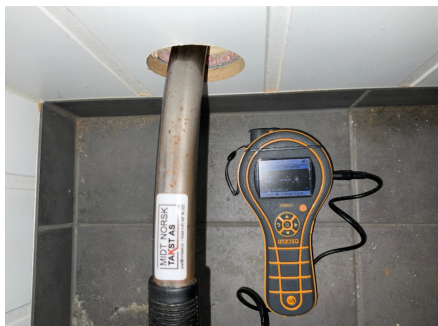
Fuktmåling bak vaskemaskin på vaskerom.
