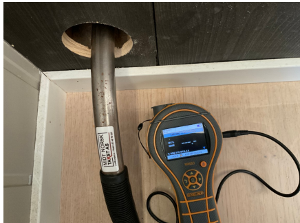
Fuktmåling fra stue mot dusjhjørne på bad.
