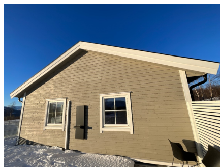
Oversiktsbilde av yttervegg.
