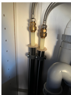
Utbedring av tettemuffer utført av eier etter befaring. Billedokumentasjon tilsendt 09.02.2026.
