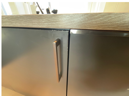
Avskalling av maling på enkelte fronter.
