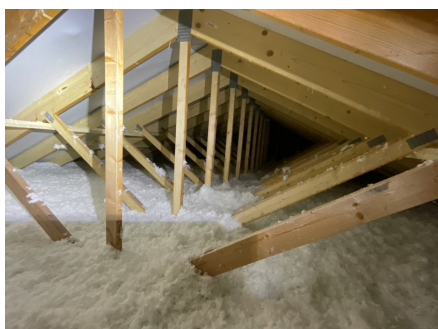
Oversiktsbilde av takkonstruksjon på kaldloft.
