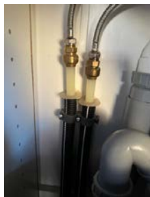
Utbedring av tettemuffer utført av eier etter befaring. Bildedokumentasjon tilsendt 09.02.2026.
