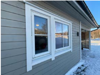
Malte trevinduer med 3-lags glass fra 2019.
