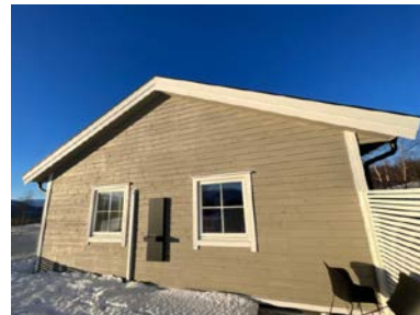
Oversiktsbilde av yttervegg.
