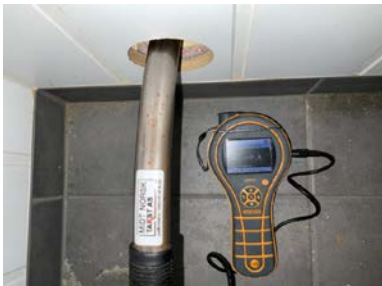
Fuktmåling bak vaskemaskin på vaskerom.
