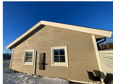
Oversiktsbilde av yttervegg.
