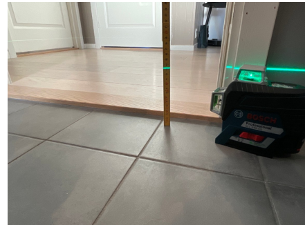
Laser plassert ved dørterskel
