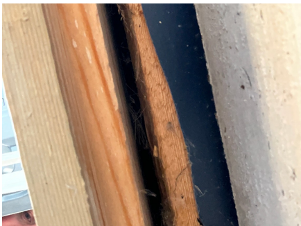
Løsning med luftespalte bak nederste kledningsbord.
