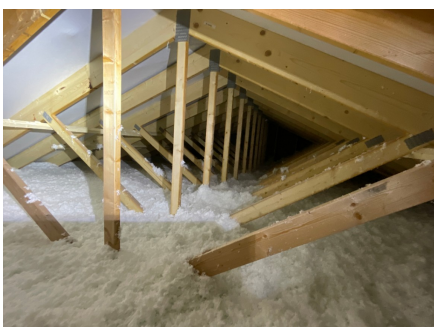
Oversiktsbilde av takkonstruksjon på kaldloft.
