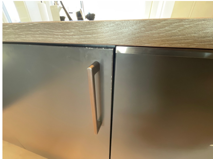
Avskalling av maling på enkelte fronter.
