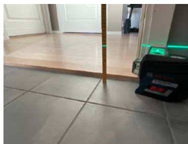
Laser plassert ved dørrterskel
