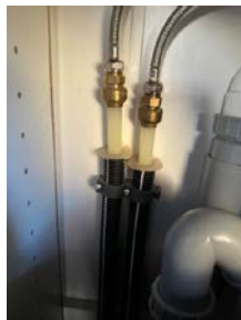
Utbedring av tettemuffer utført av eier etter befarig. Bildedokumentasjon tilsendt 09.02.2026.
