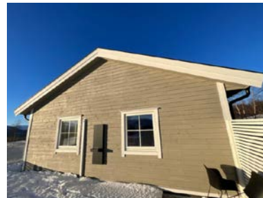
Oversiktsbilde av yttervegg.
