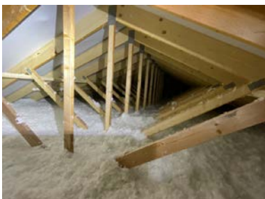
Oversiktsbilde av takkonstruksjon på kaldloft.
