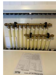
Merking av rørskap utført av eier etter befarig. Bildedokumentasjon tilsendt 09.02.2026.
