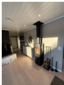
Boligen har isolert stålpipen og vedovn på stue.
