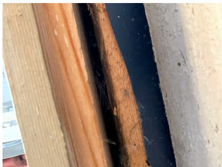
Løsning med luftespalte bak nederste kledningsbord.
