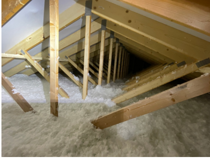
Oversiktsbilde av takkonstruksjon på kaldloft.
