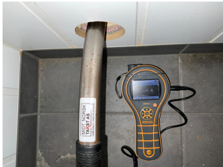
Fuktmåling bak vaskemaskin på vaskerom.
