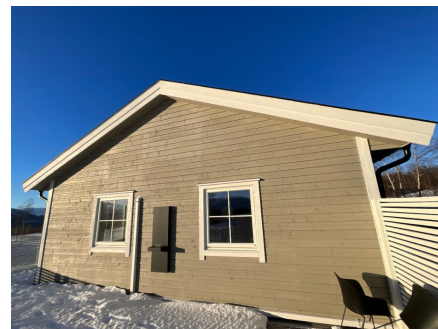
Oversiktsbilde av yttervegg.
