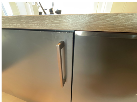
Avskalling av maling på enkelte fronter.
