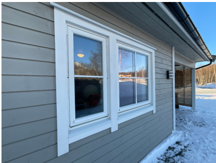
Malte trevinduer med 3-lags glass fra 2019.
