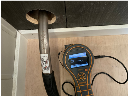
Fuktmåling fra stue mot dusjhjørne på bad.
