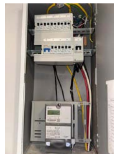
Sikringsskap med automatsikringer.
