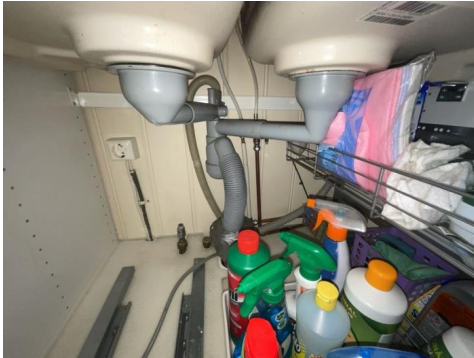
Avløpsrør i plast ført mot støpejern.
