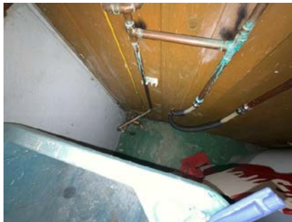
Utsnitt kobberrør og rør-i-rør.
