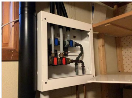
Rørskap for nyere bad i 1. etasjen.
