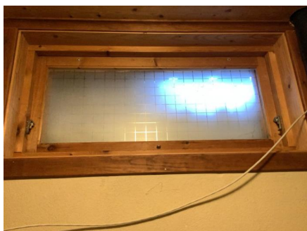
kjellervindu fra byggeår.
