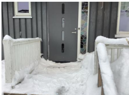
Trapp ved inngang.
