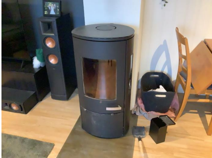
Rentbrennende vedovn i underetasje/kjeller.
