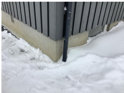
Takvann ført ned i grunnen.
