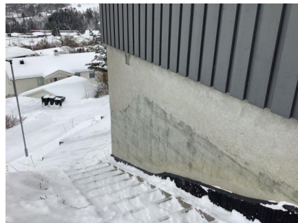
Terrenget er senket for etablering av utleiedel.
