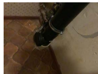
Stakemulighet på hoved-avløpsledning.
