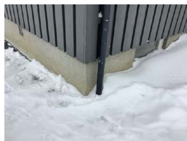
Takvann ført ned i grunnen.
