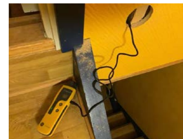
Hulltaking for fuktmåling i tilstøtende konstruksjon.
