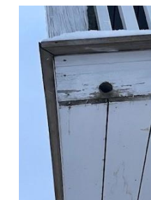
Anbefaler å sjekke tekking og avløp på balkong når snøen er borte.
