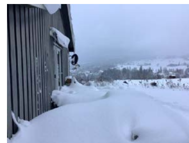
Veranda og balkong er ikke kontrollert pga snø.
