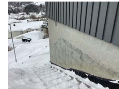
Terrenget er senket for etablering av utleiedel.
