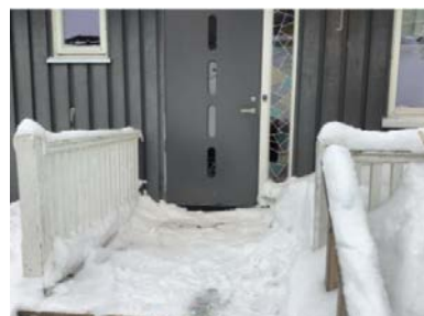
Trapp ved inngang.
