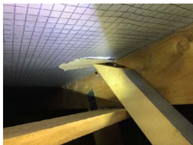
Bilde av midlertidig reparasjon av undertak fra innside.
