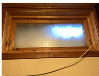
kjellervindu fra byggeår.
