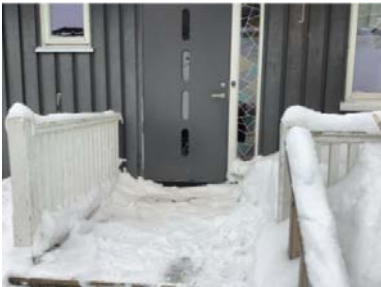
Trapp ved inngang.
