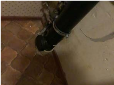
Stakemulighet på hoved -avløpsledning.
