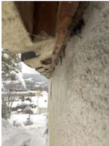
Lufting bak kledning er ikke iht dagens krav.
