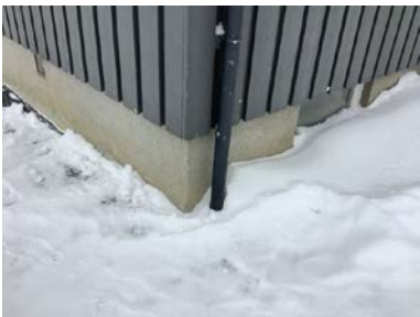
Takvann ført ned i grunnen.
