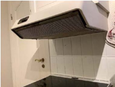
Lav høyde på avtrekksvifte.
