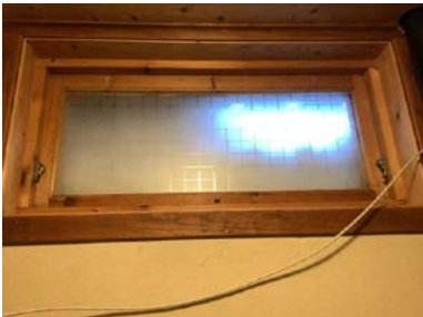
kjellervindu fra byggeår.
