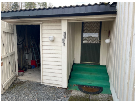
Trapp til vindfang.
