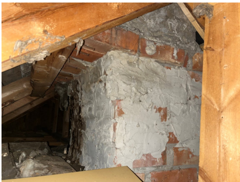
Teglsteinspipe på møneloft.
