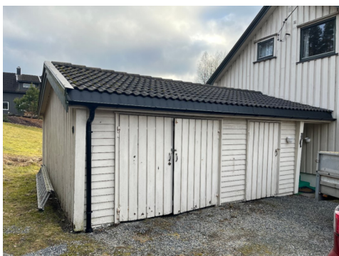
Tilliggende garasje og bod.
