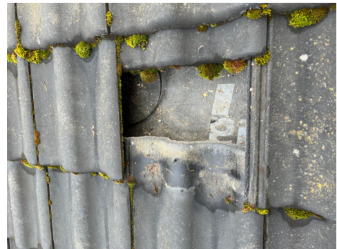
Takstein og undertak på garasje/bod-del.
