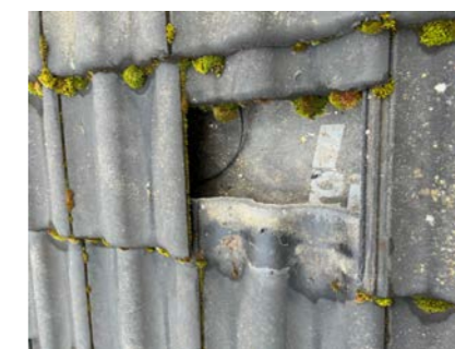
Takstein og undertak på garasje/bod-del.
