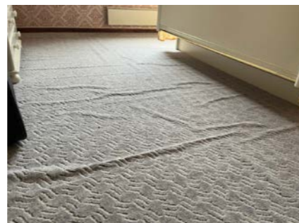
Vegg-til-vegg teppe i loftetasje har slitasje og bretter.
