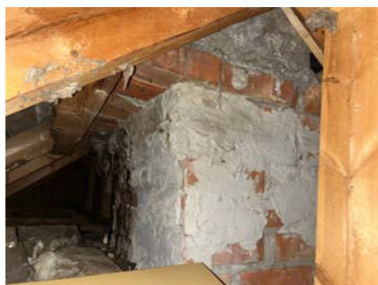
Teglsteinspipe på møneloft.
