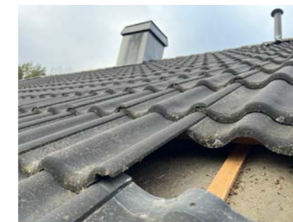
Takstein og undertak på bolig-del.
