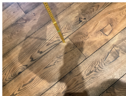
Kontroll i kjøkken / spisestue
