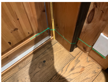
Kontroll i kjøkken / spisestue
