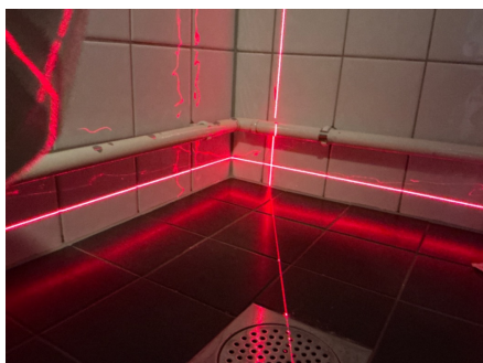
Fall på baderomsgulv er kontrollert med krysslaser.
