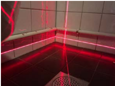
Fall på baderomsgulv er kontrollert med krysslaser.
