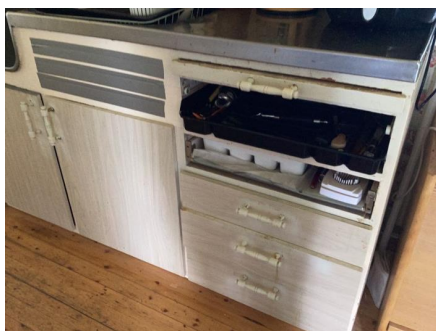
Det mangler noen skuffefronter.
