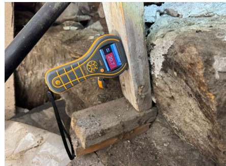
Fuktmåling i søyle.
