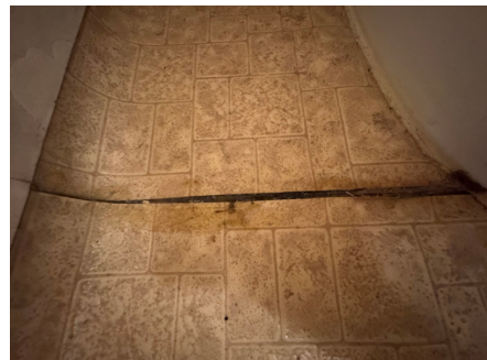
Eksempel på utettheter i vinylbelegg.
