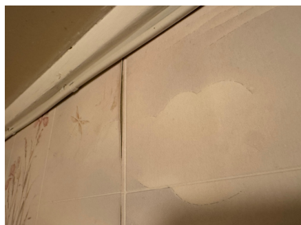
Eksempel på utettheter i våtromstapeten.
