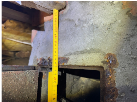
Avstand til brennbart materiale fra sotluke i krypkjelleren.
