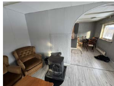
Pipen er kledd inn over brannmur.
