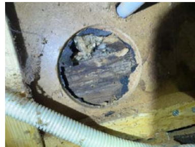
Råteskadet trevirke.
