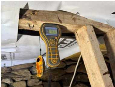
Fuktmåling i drager.
