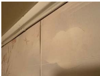
Eksempel på utettheter i våtromstapeten.
