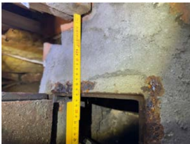
Avstand til brennbart materiale fra sotluke i krypekjelleren.
