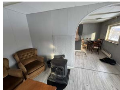
Pipen er kledd inn over brannmur.
