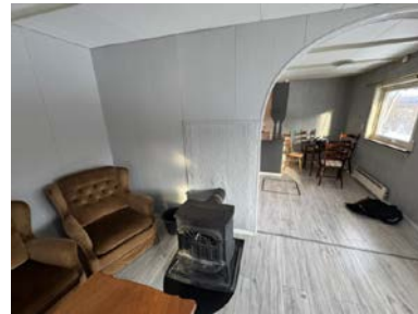
Pipen er kledd inn over brannmur.
