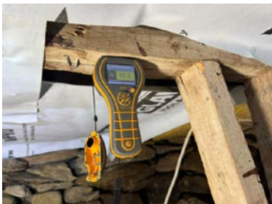
Fuktmåling i drager.
