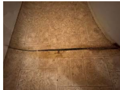
Eksempel på utettheter i vinylbelegg.
