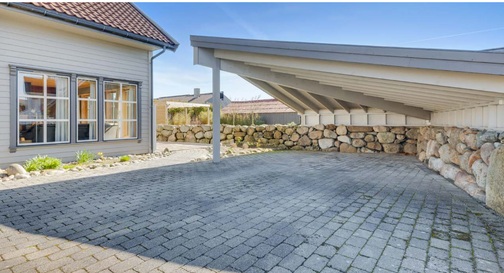
Uteområde med overbygd uteplass (brukt til carport, ikke godkjent).
