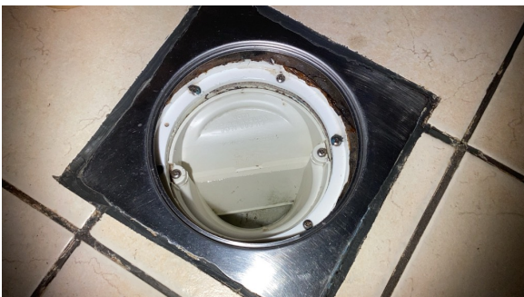
Kontroll av sluk.
