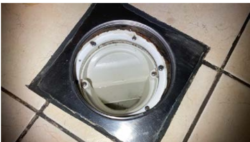
Kontroll av sluk.
