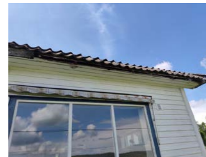
Mangler forkantbord. Synlig råte i undertak og lekter.
