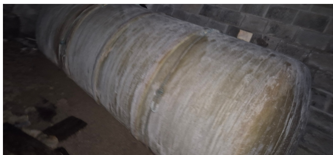
Glassfiber oljetank i kjelleren
