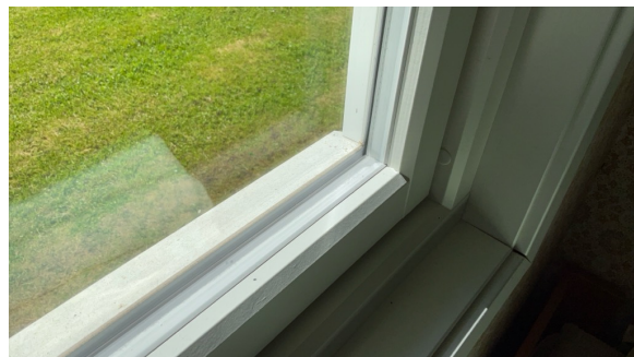
Endel vinduer fra 2014 og 2016.
