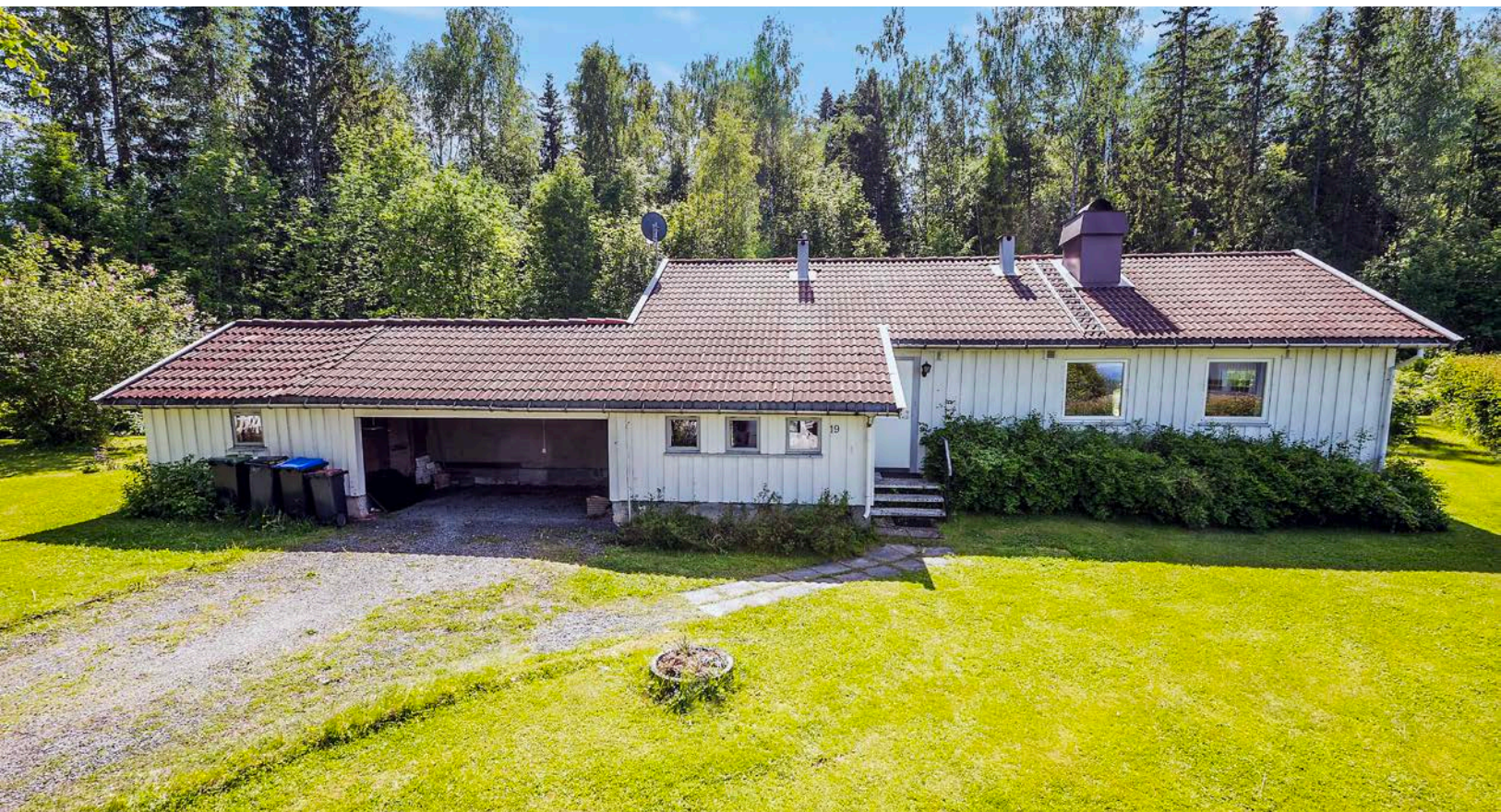
Inntillbygget carport/ boder.
