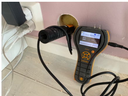
Fuktmåling i vegg ved hulltaking.
