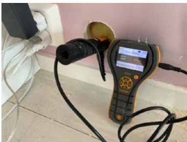
Fuktmåling i vegg ved hulltaking.
