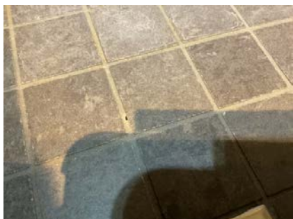
Hull i fugemasse
