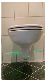
Manglende drenshull/synliggjøring av lekkasje fra veggmontert sisterne.
