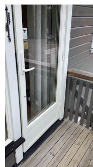
Merker/oppskrapping i karm og dørhåndtak.
