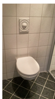
Manglende drenshull/synliggjøring av lekkasje fra veggmontert sisterne.
