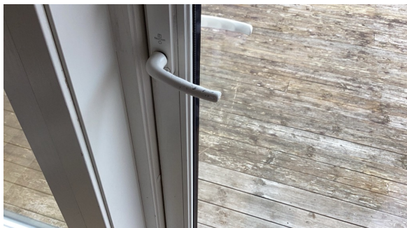
Merker/oppskrapping i karm og dørhåndtak.
