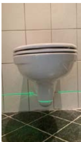
Manglende drenshull/synliggjøring av lekkasje fra veggmontert sistene.
