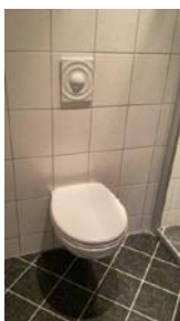
Manglende drenshull/synliggjøring av lekkasje fra veggmontert sistene.
